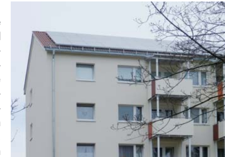
Ausnutzung der Dachflächen zur Befestigung der Photovoltaikanlage.
