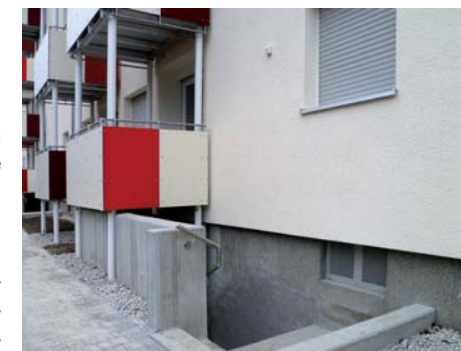
Neugestaltete Kellerniedergänge in Sichtbeton.
