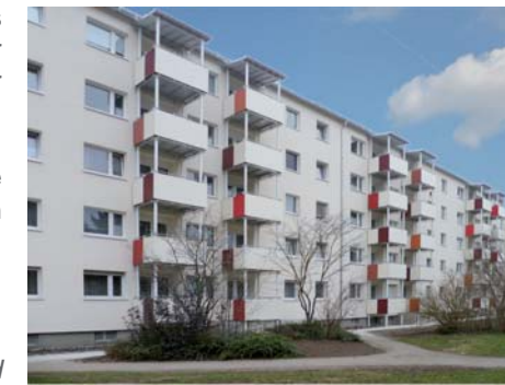
Hell gestaltete WDVS-gedämmte Fassade mit vorgestellten Balkonsystemen.
