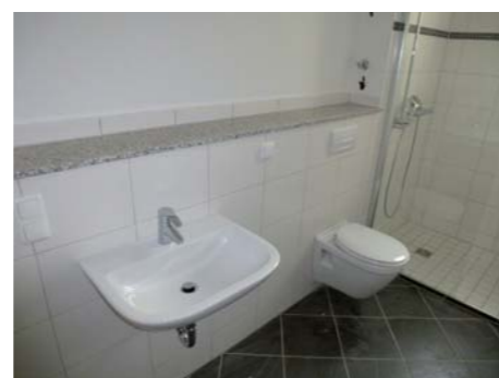
Badgestaltung mit bodengleicher Dusche
