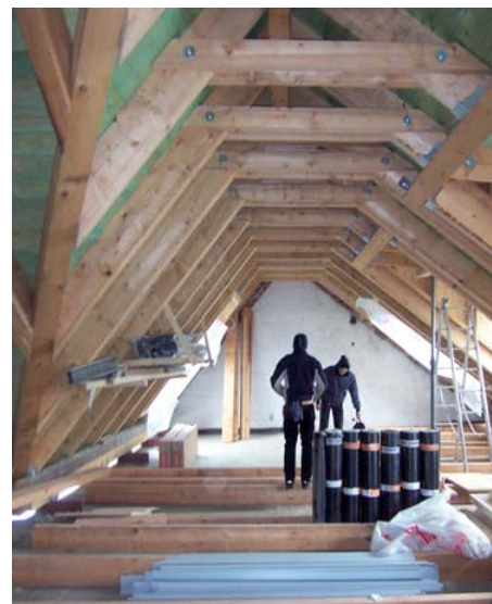
Dachgeschossausbau im Sanierungsobjekt „Brahmsstraße Ecke Zauberstraße“
