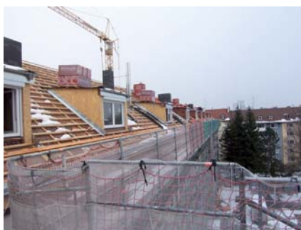
Dachdeckungs- und Zimmererarbeiten am Objekt
