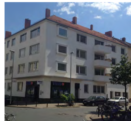
Sanierungsobjekt Türkstraße 4 und 4A
