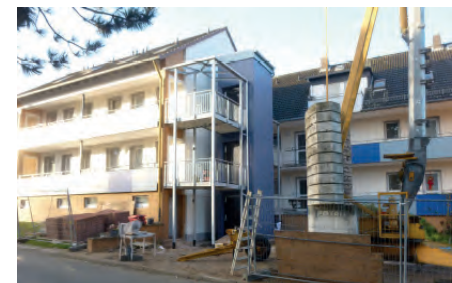
Montage des Außenaufzuges
