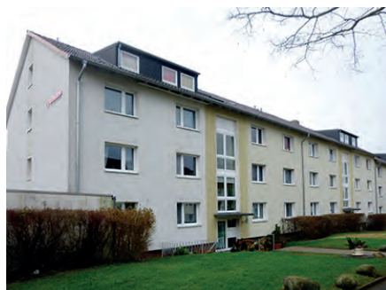
Das Sanierungsobjekt Willi-Plappert-Straße
