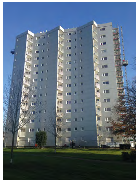
Fassadenansicht Hessische Straße 91
