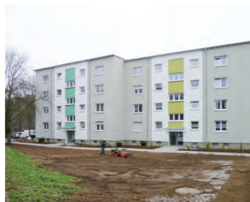
Letzte Arbeiten an den Außenanlagen
