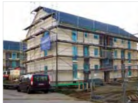
Anbringung des WDVS-Systems
