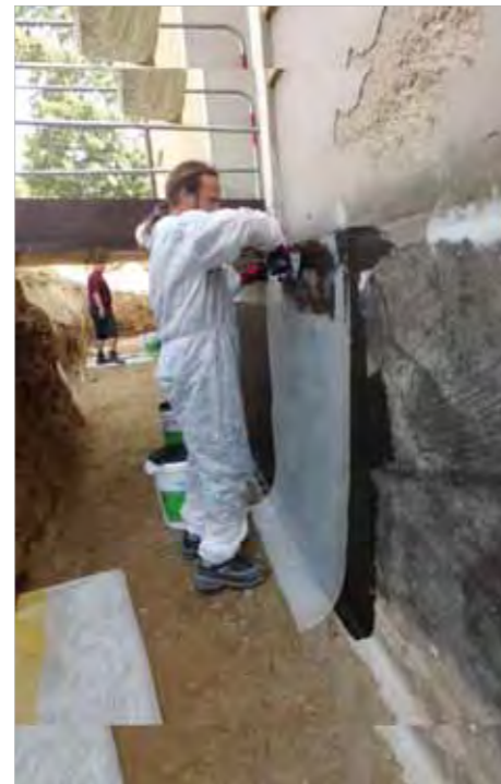
Bauwerksabdichtung in der Kellerbergsiedlung
