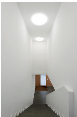
RZB | Flat Polymer® LED mit Bewegungsmelder | Treppenhausbelleuchtung in Berliner Wohnanlage | Zanderroth Architekten | Berlin
