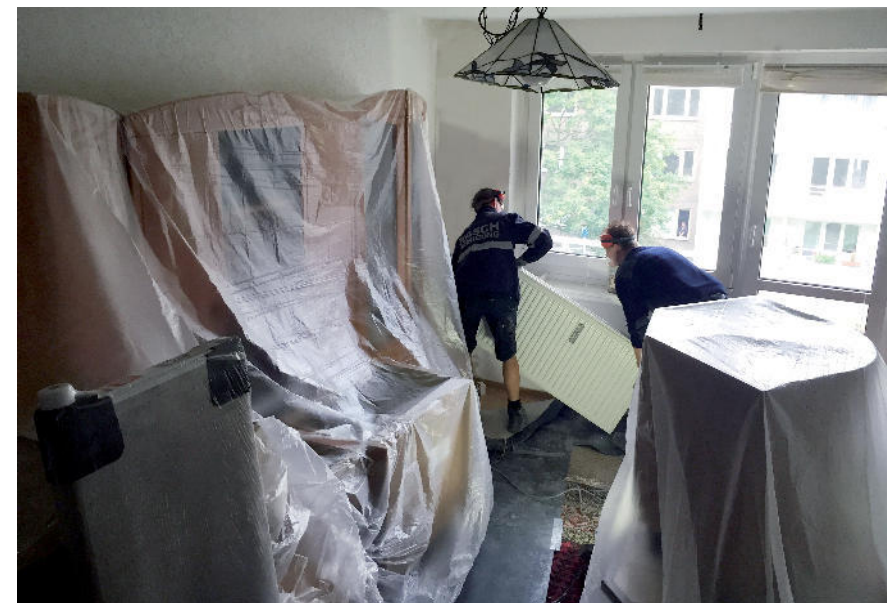
Magdeburg, Dequeder Str. 5-8, Rückbau des Heizungsstranges unter bewohnten Bedingungen.
