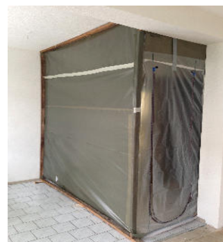
Staubschutzschleuse zum Schutz der noch bewohnten Wohnungsabschnitte
