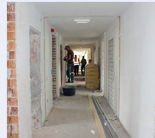
Neugestaltung der Zugangsflure
