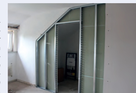
Trockenbauarbeiten zur Badabtrennung
