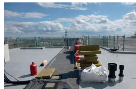
Dachabdichtungsarbeiten
