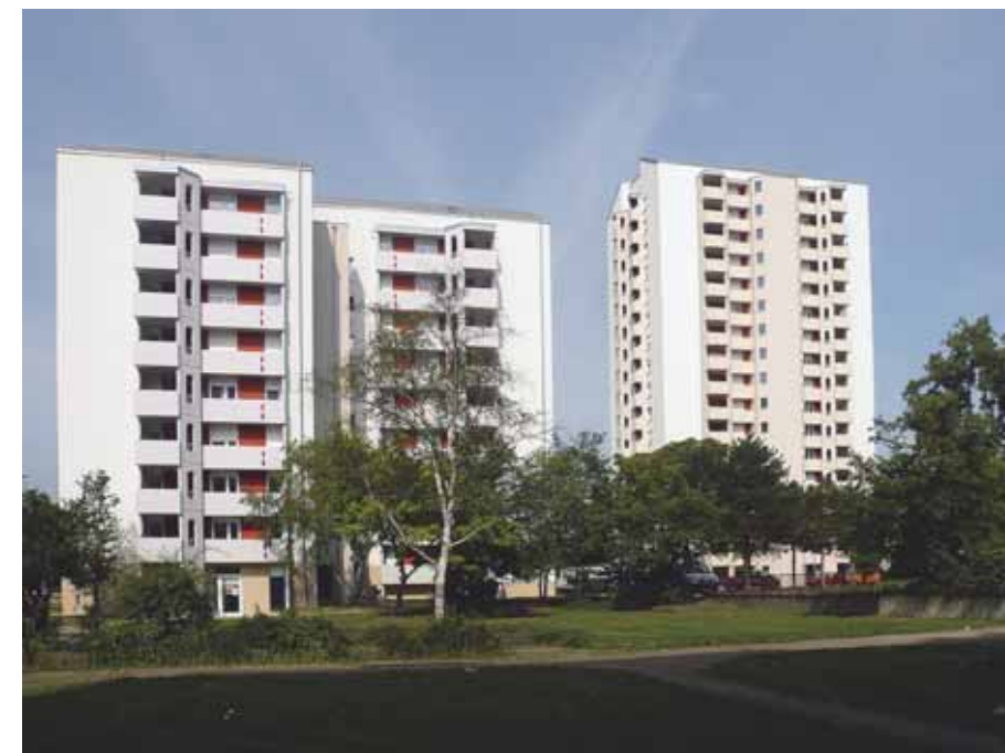
Die von der MACON BAU GmbH Magdeburg sanierten Punkthochhäuser Heilbronner Str. 22 und 24 in Karlsruhe, Rintheimer Feld
