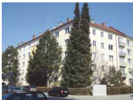
München, Brahmstraße 10-14 und Zauberstraße 33 vor der Sanierung
