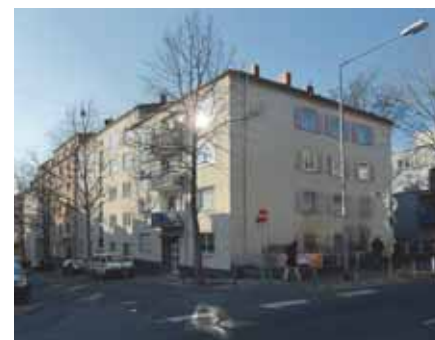
Wiesbaden, Walramstraße 32-34 vor der Sanierung
