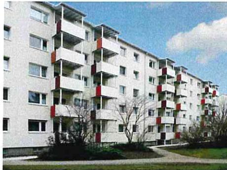
*Hell gestaltete WDVS-gedämmte Fassade mit vorgestellten Balkonsystemen*
