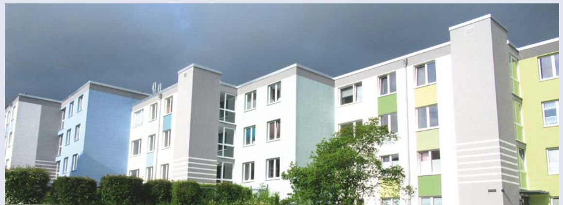
Fernansicht mit vorgestellten Aufzugstürmen
