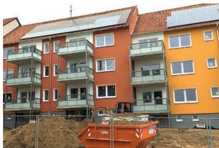
Endphase der Sanierung, 10/2018
