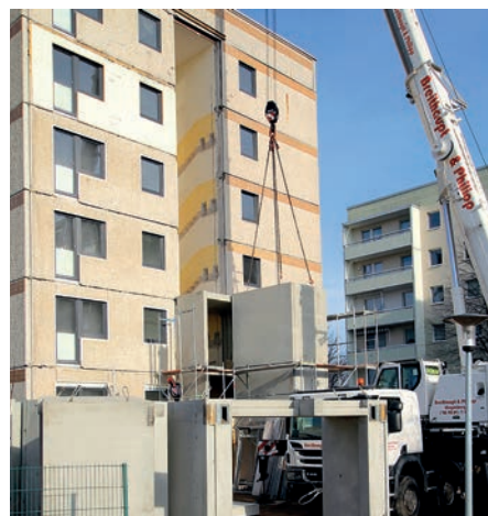
Fertigteilmontage Treppe und Aufzug 01/2019
