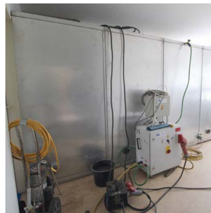
Asbest-4-Kammer-Schleuse im Aufbau, 05/2019
