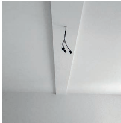
fertiger Deckenkanal aus Gipskarton
