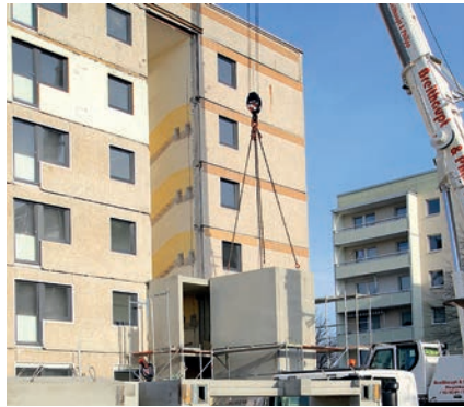
Fertigelemente für Treppenhaus und Aufzugsturm
