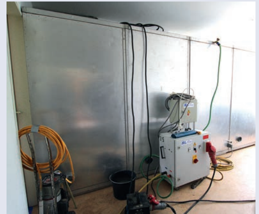
Aufbau der 4-Kammer-Schleuse
