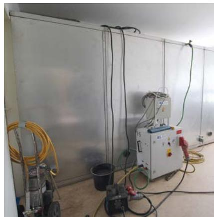
Asbest-4-Kammer-Schleuse im Aufbau, 05/2019
