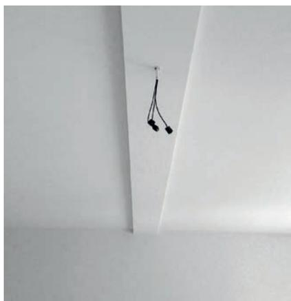
fertiger Deckenkanal aus Gipskarton
