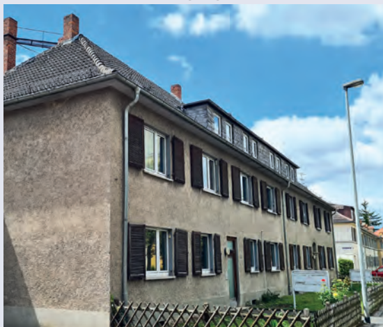
vor der Sanierung
