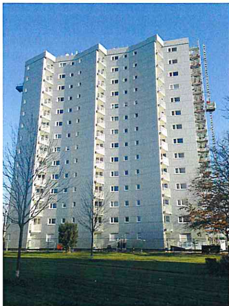
Fassadenansicht Hessische Straße 91
