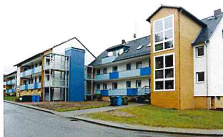
Fassadenansicht Friedrich-Ebert-Straße 1/1a
