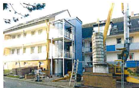
Montage des Außenaufzuges
