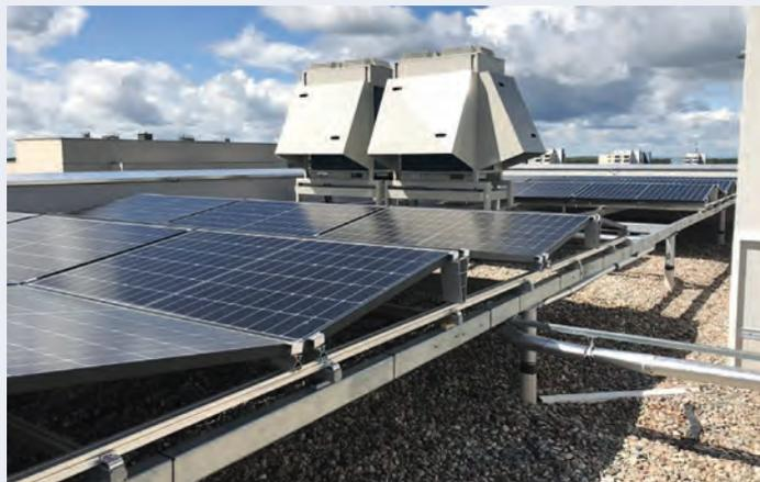
Photovoltaikanlage und zwei Wärmepumpen auf dem Dach
