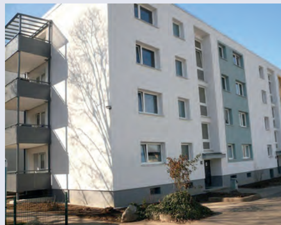
Hausnr. 106-108 nach der energetischen Sanierung
