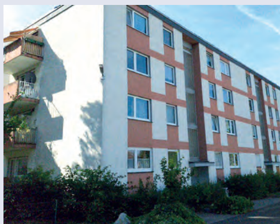
Hausnr. 106-108 vor der energetischen Sanierung
