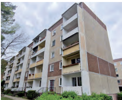
Plattenbauten vor Sanierung
