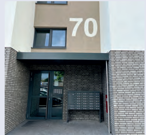
HE geklinkert, neues Vordach m. BK-Anlage
