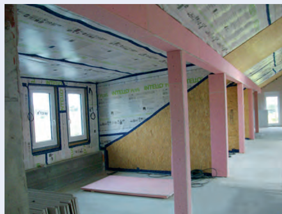
Dachstuhlerneuerung mit Gauben
