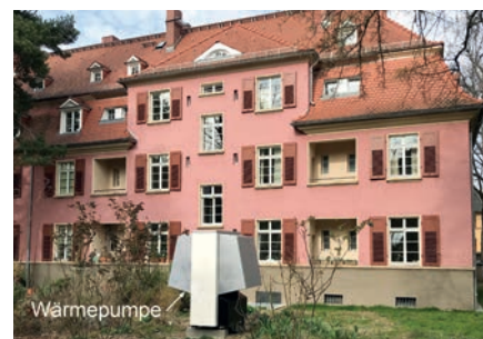
Hofansicht mit Wärmepumpe
