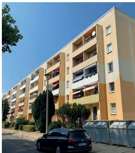
Sanierung unter bewohnten Bedingungen
