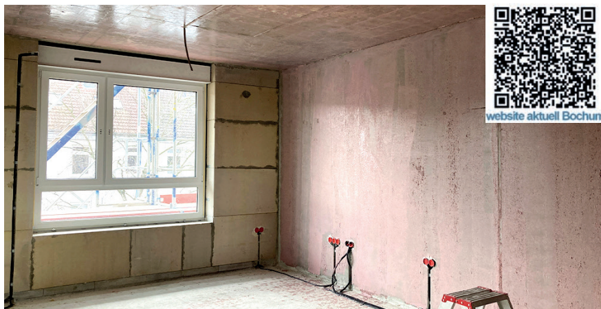
Bochum, Ausbaupaket, Fenstereinsatz und Elektroinstallation, Foto: 20.02.2025
