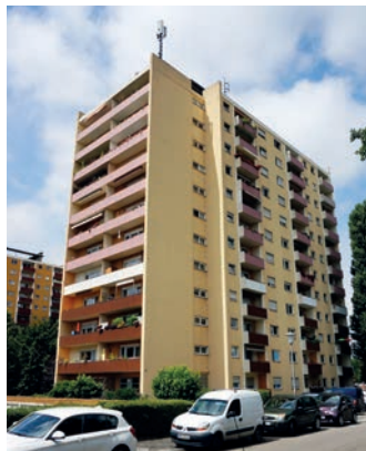
Mannheim, Murgstr., vor und nach Sanierung
