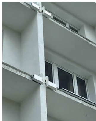
Wolmirstedt, „Hockeyschläger“ für Aufnahme der Konstruktion, re. Montage
