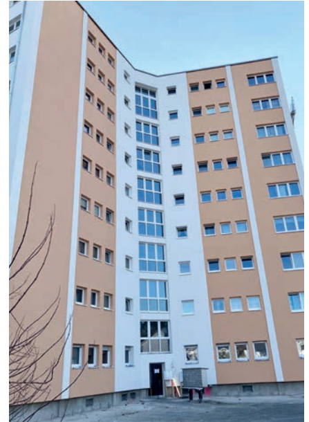
K.-S.-Ring 81, WDVS-Fassade, Foto: 19.02.2025
