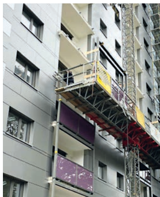
Mannheim, Montage des BALCO-Systems, re. Fertigstellung der Loggia
