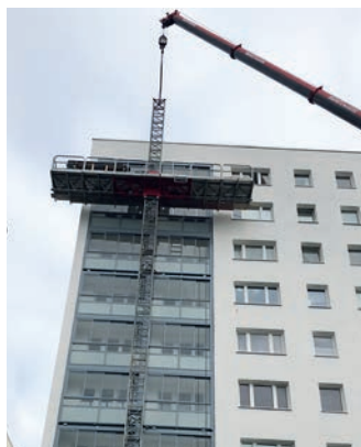
Wolmirstedt, „Hockeyschläger“ für Aufnahme der Konstruktion, re. Montage
