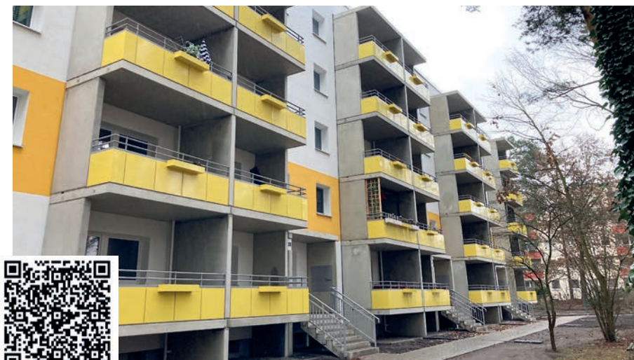
WDVS-Fassade und neue Balkon- u. Eingangsanlagen, Foto: 29.08.2024
