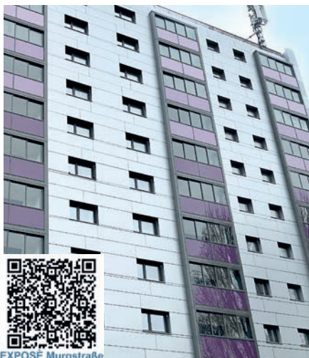
EXPOSE Murgstraße Mannheim, Murgstr., BALCO-Balkonverglasung, Foto: 21.08.24
