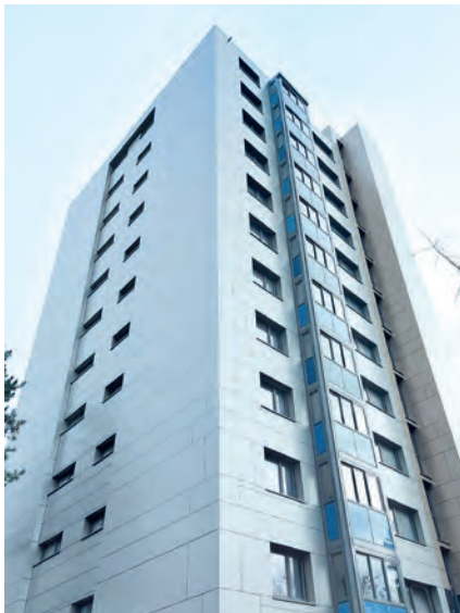
Nr.15, Alucobond®-Fassade, Foto: 03.07.2025
