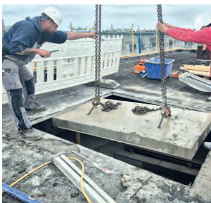
Fahrstuhlschacht per Kran, Foto: 21.10.2024
